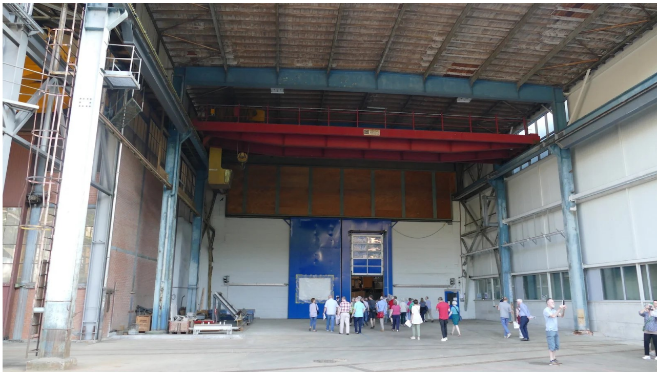
Links die Halle 7, die ebenfalls erhalten bleibt. Rechts entsteht ein Neubau.
