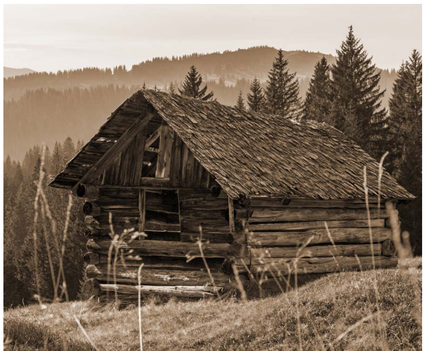
Wenn Waldhütten «saniert» werden und daraus ohne die nötige Bewilligung Ferienhäuser ausserhalb der Bauzonen werden, will die Stadt Kriens in Zukunft genau hinsehen. (Symbolbild)
