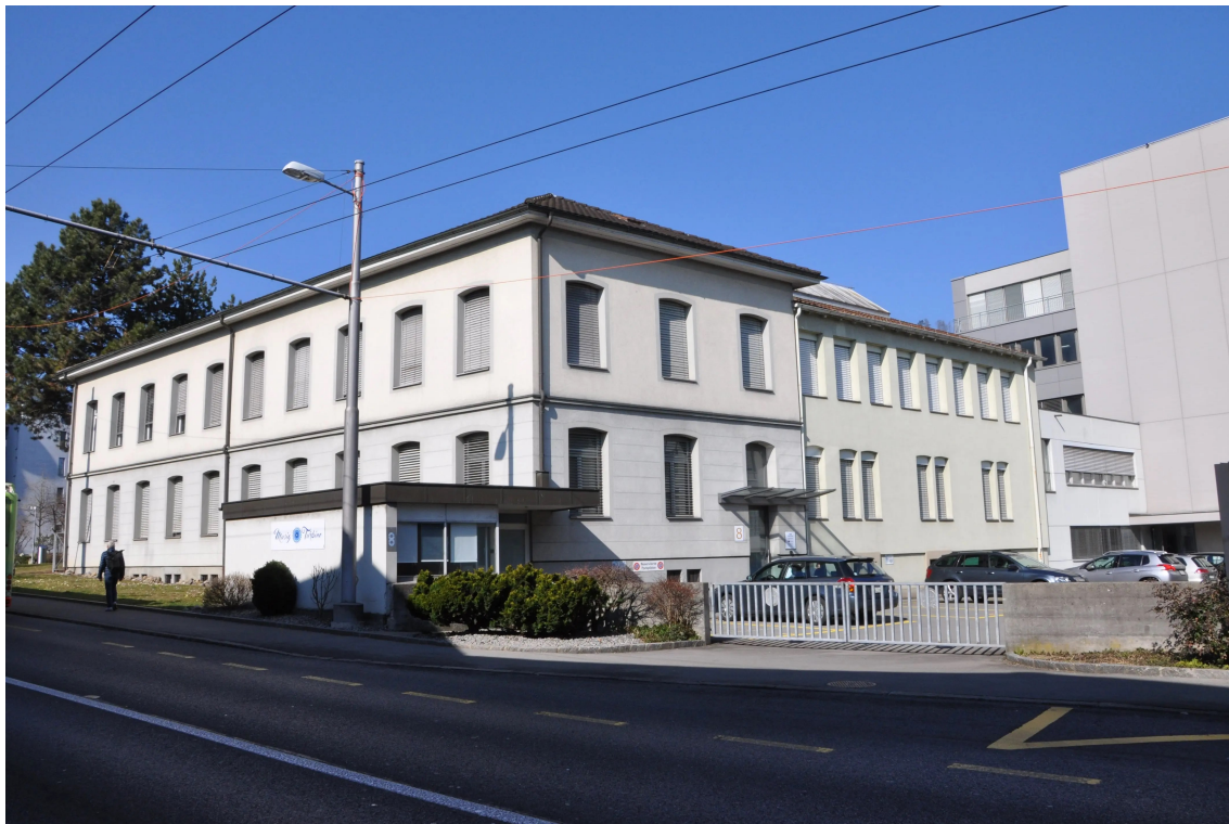
In diesem Gebäude sollen Ateliers und Arbeitsplätze für Kreative und Kulturschaffende entstehen. Bild: PD
